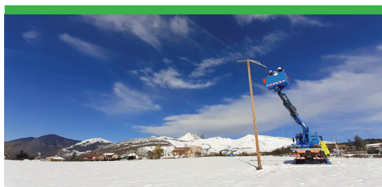
Intervention Enedis dans les Alpes du Sud
