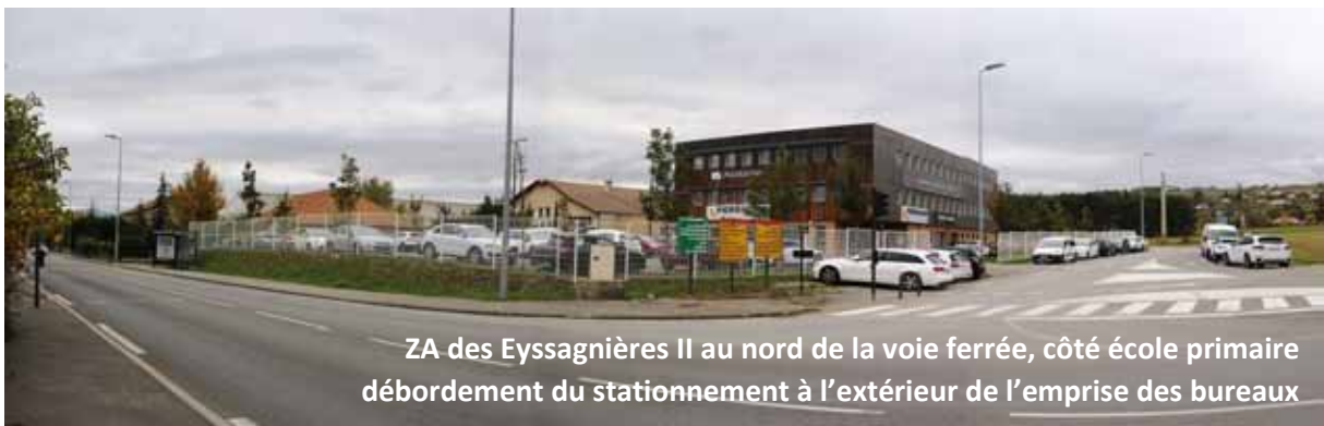
ZA des Eyssagnières II au nord de la voie ferrée : utilisation « timide » de l'effet de vitrine
