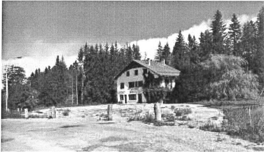
Ancien commerce à démolir
