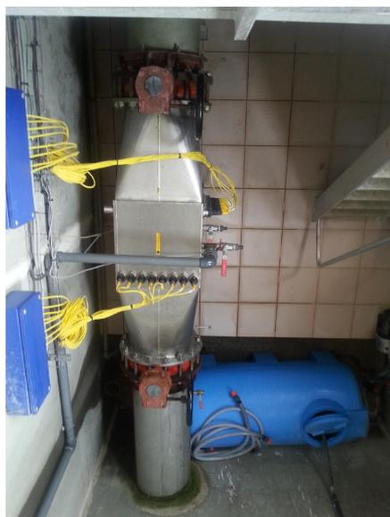
La coagulation en ligne est essentiellement effectuée sur les périodes allant du printemps à l'automne. Sauf situation particulière, ce traitement n'est pas nécessaire pour traiter l'eau en période hivernale. Une petite pompe doseuse est prévue pour les injections de chlorure ferrique en cas de besoin ponctuels.
